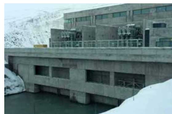
Vatnsaflsvirkjun, skoðun vegna umhverfis- og mengunarvarna.
