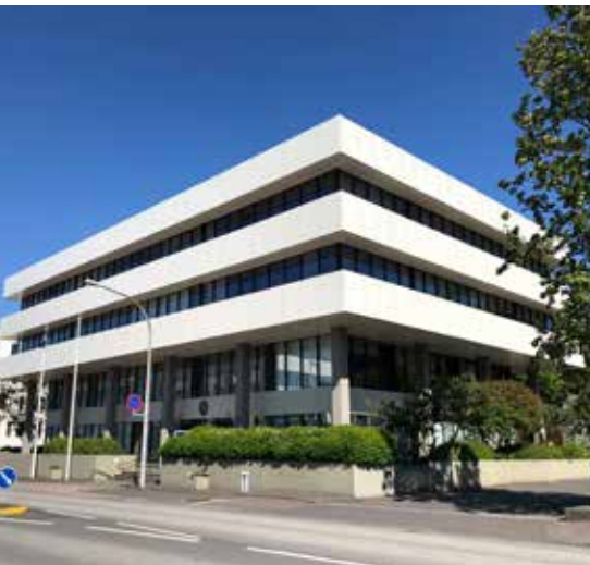
Utanríkisráðuneytið við Rauðarárstíg.
