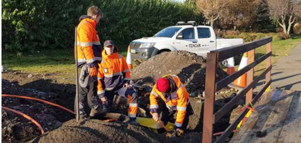
Starfsmenn Netkerfa vinna við lagningu ljósleiðara Tengis á Akureyri.
