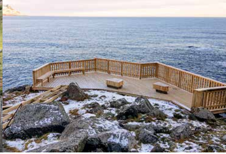
Verið að leggja lokahönd á útsýnisvall við Skálanes í Seyðisfirði. Verkráð sá um hönnun fyrir Seyðisfjarðakaupstað.
