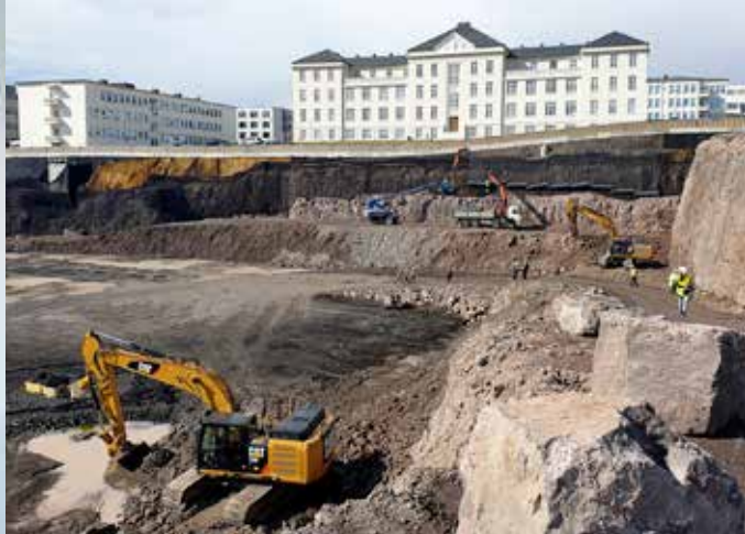
Jarðvinna vegna byggingar meðferðarkjarna nýs Landspítala, komin vel á veg sumarið 2020.
