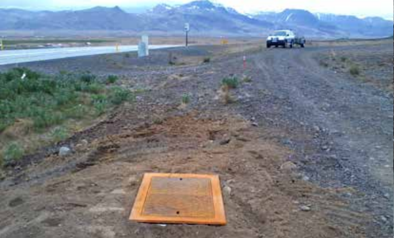
Niðurstetning á brunni
