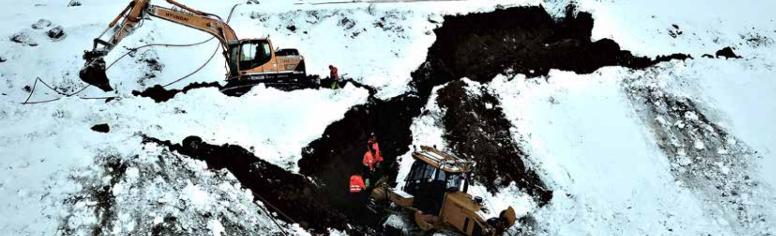
Starfsmenn Tengis hf. í vinnu við krefjandi aðstæður við að koma ljósleiðara og stýrisstreng upp Hlíðarfjall veturinn 2019.
