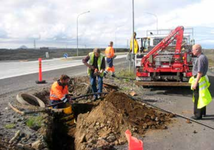
Unnið við fjarskiptalagnir.
