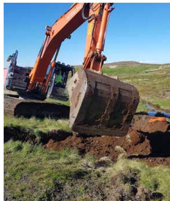
Niðurstetning á brunni.
