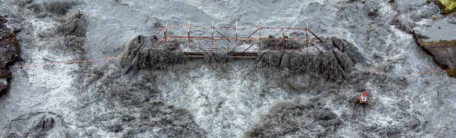
Ljósleiðaralögn sem eyðilagðist í síðasta Skaftárhlaupi. Lögnin sést hanga yfir vatninu og myndin sýnir hvað náttúruöflin geta verið óútreknanleg og erfð að eiga við.
