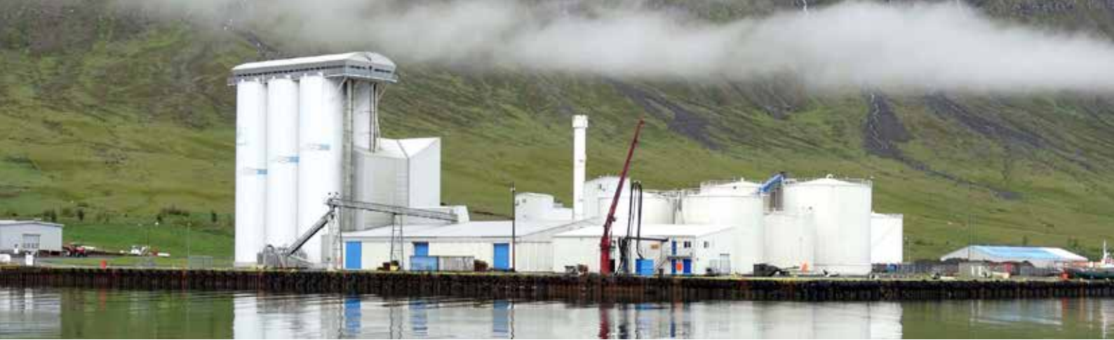
Fiskimjölsverksmiðja Sildarvinnslunnar í Neskaupstað. / Ljós. Hünbogi Sólon Gunnþórsson.
