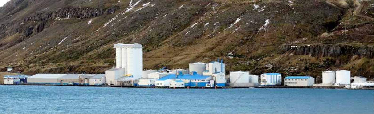
Fiskimjölsverksmiðja Sildarvinnslunnar á Seyðisfirði. Ljós. Ómar Bogason.
