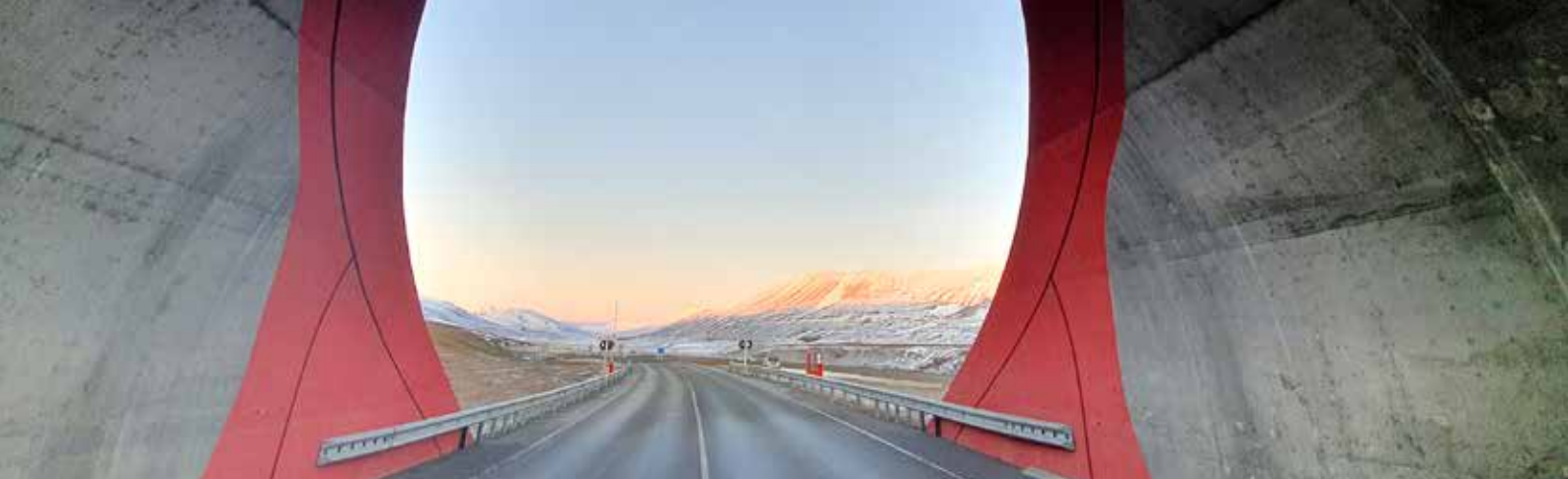
Horft úr gangamunna í Fnjóskadal.
