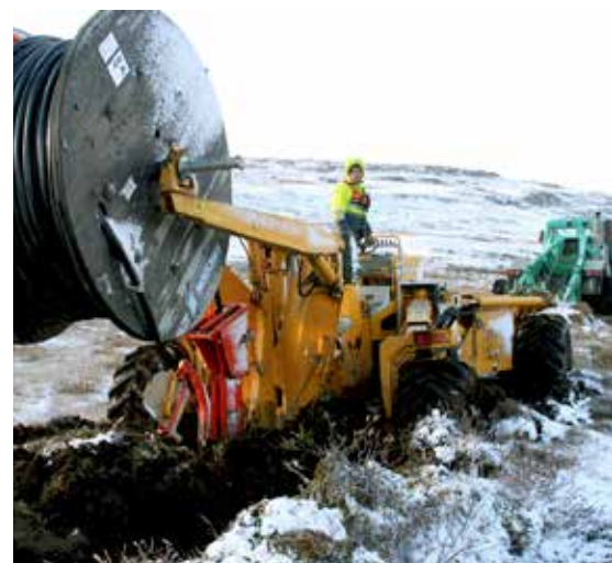
Plægning á Steingrímsfjarðarheiði. / Ljósmyndasafn OV.
