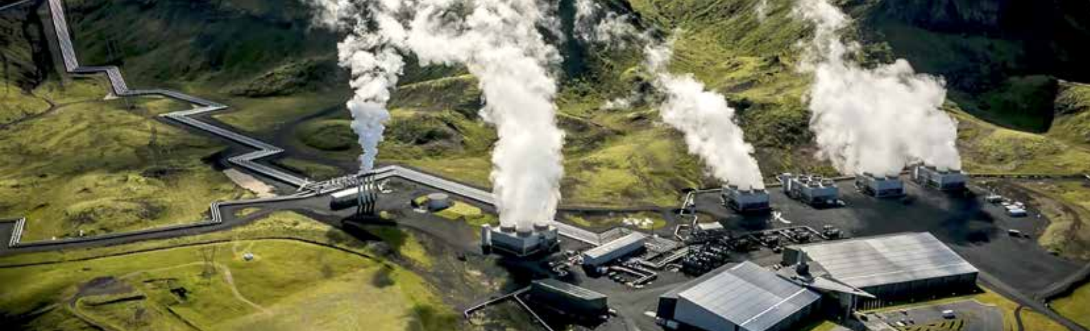
Hellisheiðarvirkjun. / Ljósmynd. Árni Sæberg.
