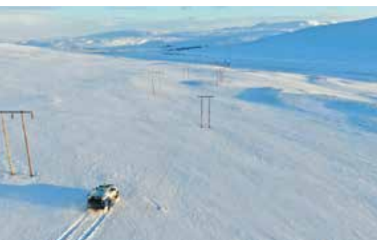
Línan frá Laxárvirkjun að Einarstöðum í Reykjadal skoðuð með drónamyndavél.
