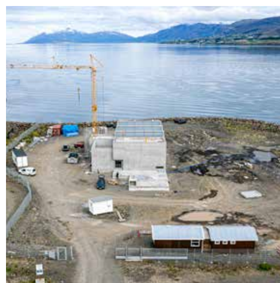
Hreinsistöð fráveitu í byggingu.
