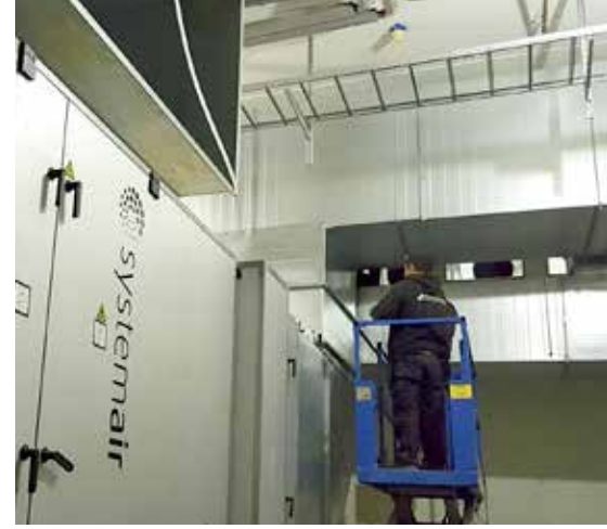
Framkvæmdir við Búrfell 2 virkjun.
