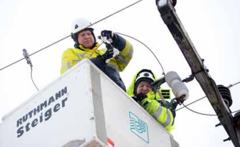
Unnið við Hafnarlinu.
