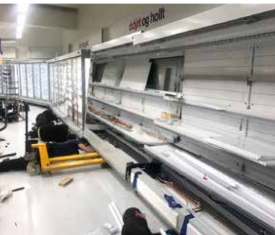
Uppsetning á kæliklefum í matvöruverslunum. KAPP er með eftirlit og sólarhringsvakt á klæibúnaðinum.
