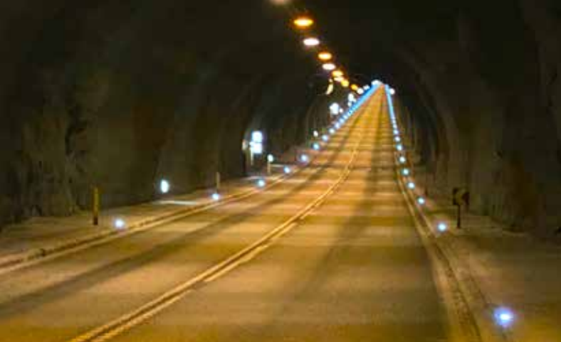
Kantlýsing í Hvalfjarðargöngum.
