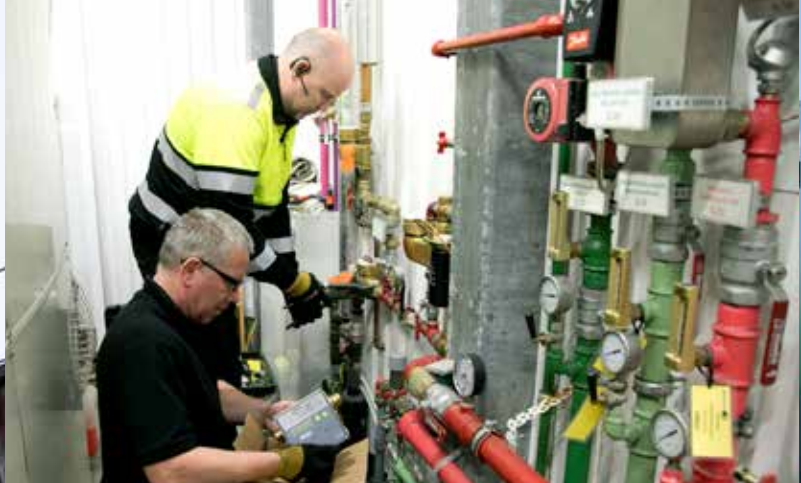
Unnið við uppsetningu snjallmælis hitaveitugrind.
