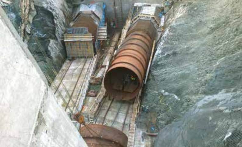
Uppsetning fallpípu í Búðarhálsvirkjun.
