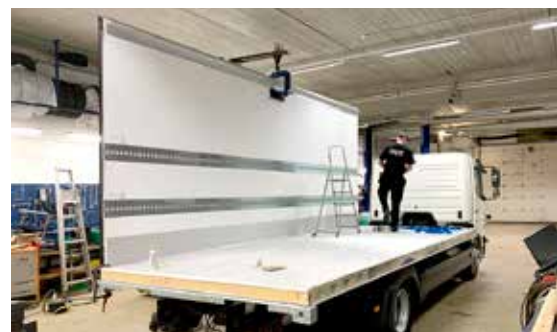
Yfirbygging vörukassa ásamt því að setja vörulyftu á nýjan sýningarbil fyrir Öskju. Billinn er af gerðinni Benz Atego1530 vörubill.
