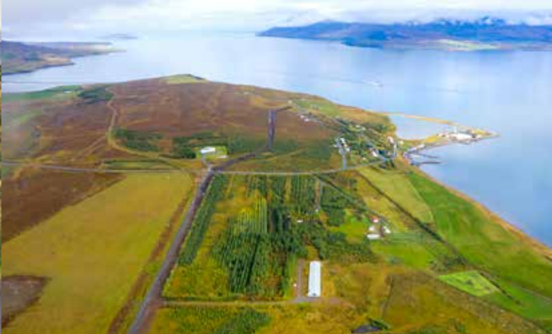
Hjalteyri. Lagning aðveituzæðar hitaveitu frá Hjalteyri til Akureyrar sumarið 2019.
