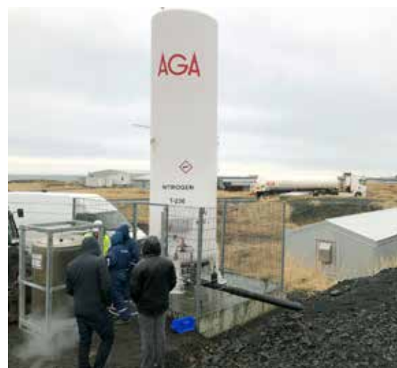
Viðskiptavinir hafa staðbundna tanka fyrir fljótandi gas sem fyllt er á með flutningsbíl.
