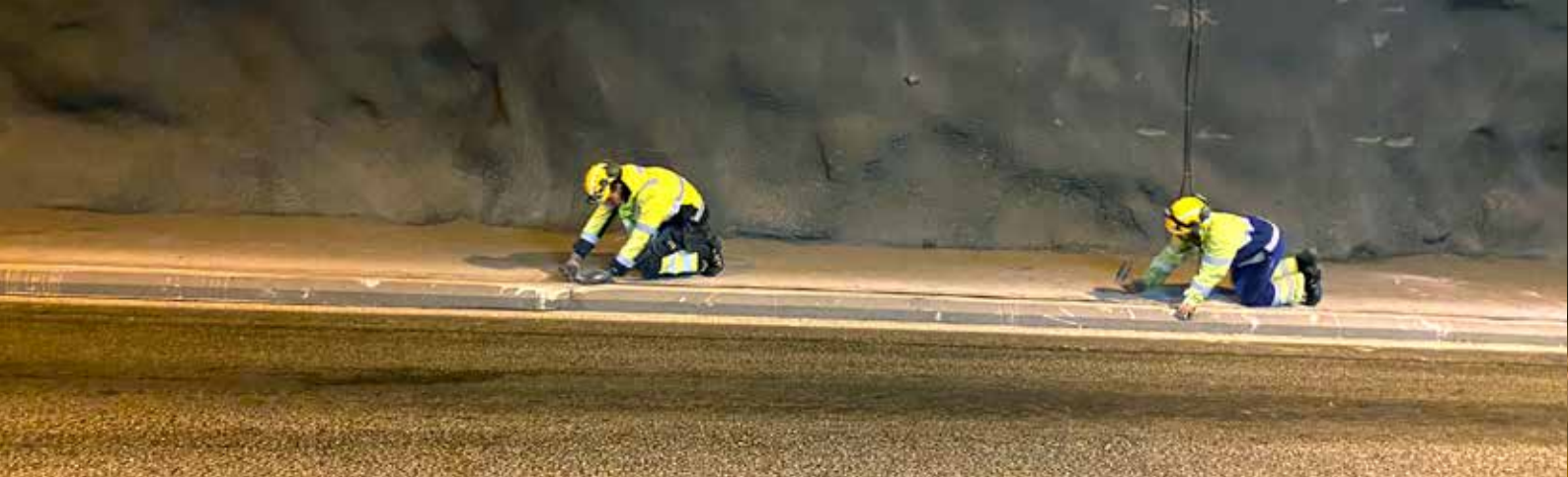
Uppsetning á kantlýsingu í Hvalfjarðargöngum.
