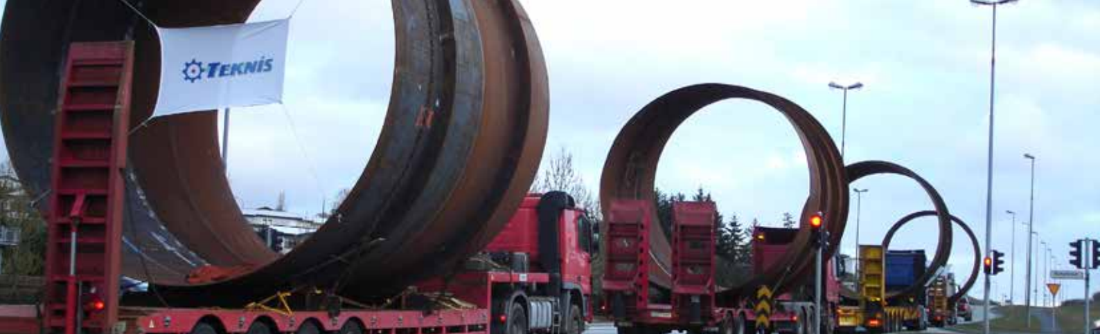
Verið að flytja fallpípurnar í Búðarhálsvirkjun.
