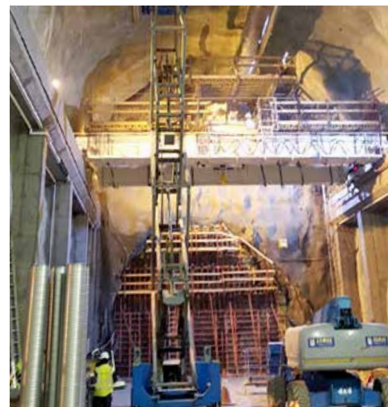
Framkvæmdir við Búrfell 2 virkjun.
