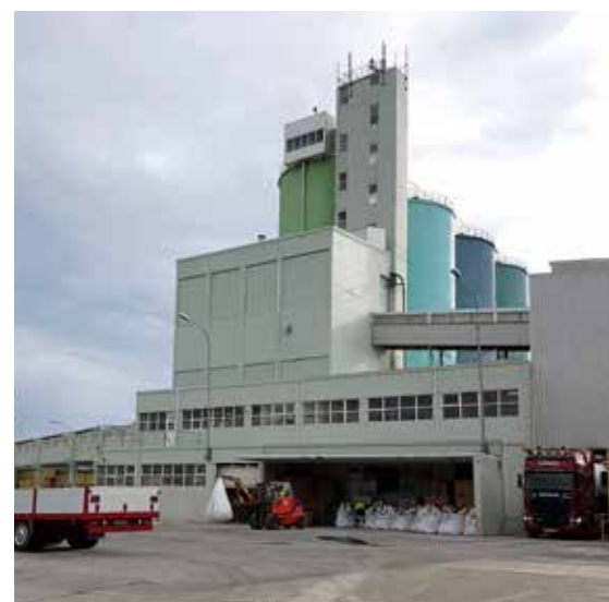
Sementsbirgðastöðin á Akranesi. Í stöðinni eru sementssíló sem taka 16.000 tonn af sementi alls. Unnið er að lestun sementsflutningabíls og afhendingu sements í stórsekkjum.
