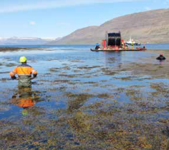
Starfsmenn OV við sæstrengslögn. / Ljósmyndasafn OV.
