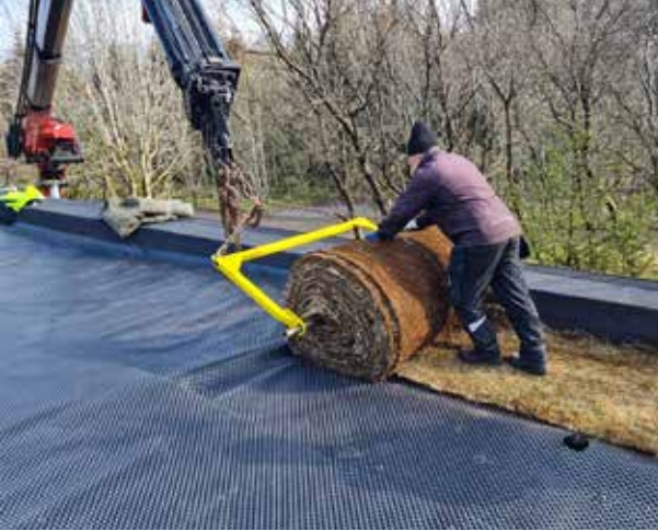
Verið að leggja út fyrir þak með grasi.
