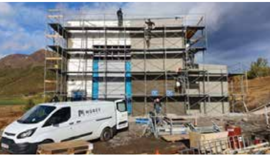
Múrverk við Hólsvirkjun haustið 2020.
