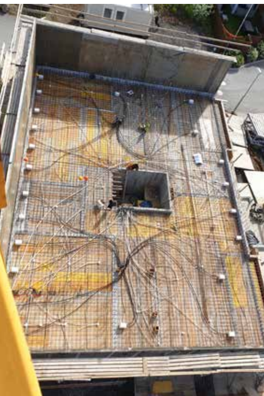
Séð ofan í steypugrunn.
