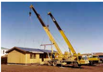
Hífing lögreglustöðvar í Stykkishólmi.
