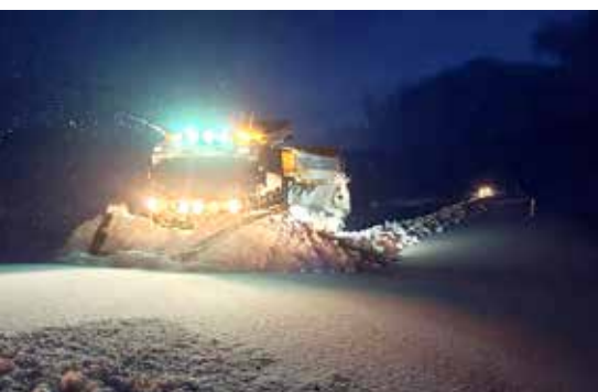
Unnið við snjómokstur á Öxnadalshéið eftir stórhrið 2019.
