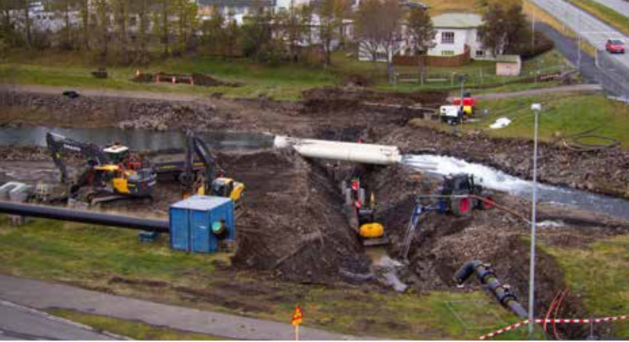
Hitaveitulögn lögð tvo metra undir botn Glerár.
