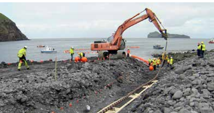
Unnið við að draga Vestmannaeyjastreng á land í Gjábackaföru í Vestmanneyjum árið 2013.
