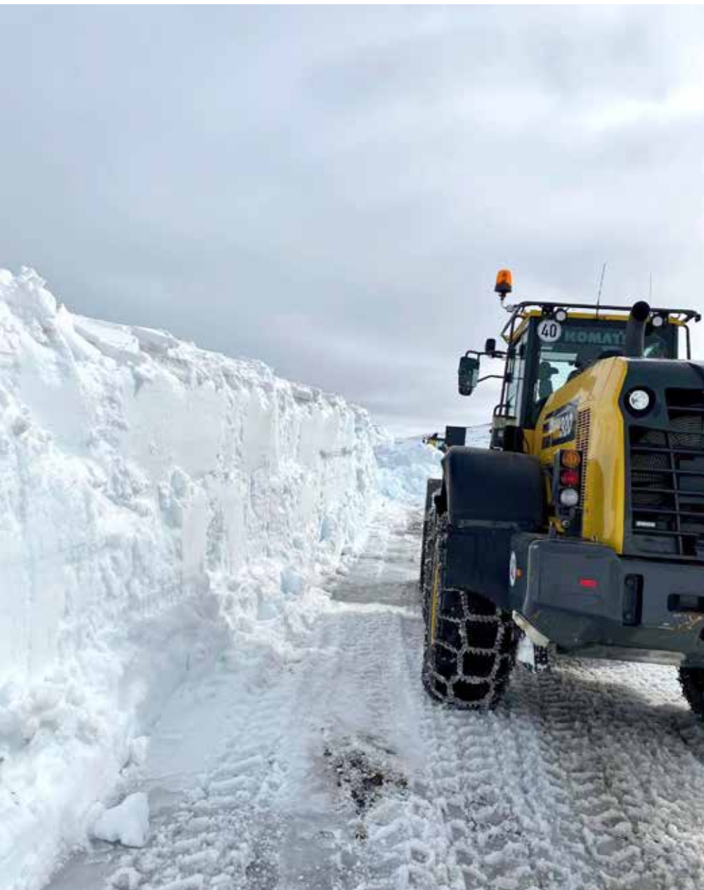
Unnið fyrir Landsnet ehf við snjóhrensun á slóðum Kröflulínu KR3-02.
