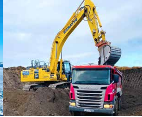
Vinna við slóðagerð í Hólasandslínu HS3-01 við Víða í Reykjadal.
