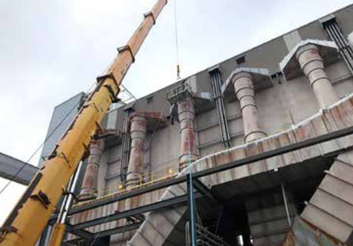
Unnið við afsogskerfi á Reyðarfirði.
