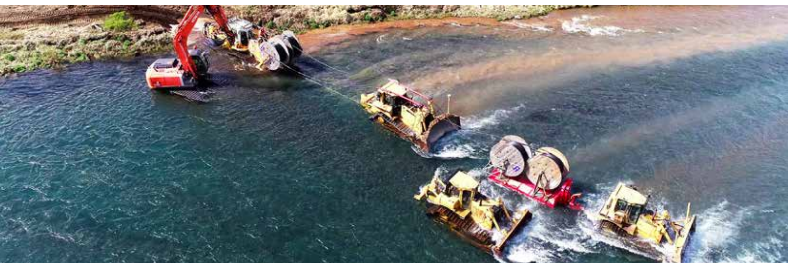
Þverun Fnjóskár í Fnjóskadal með fjóra rafmagnstrengi fyrir RARIK árið 2019.
