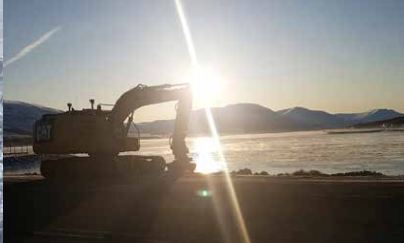
Unnið við sjóvarnir á Leiruvegi við Akureyri 2019.
