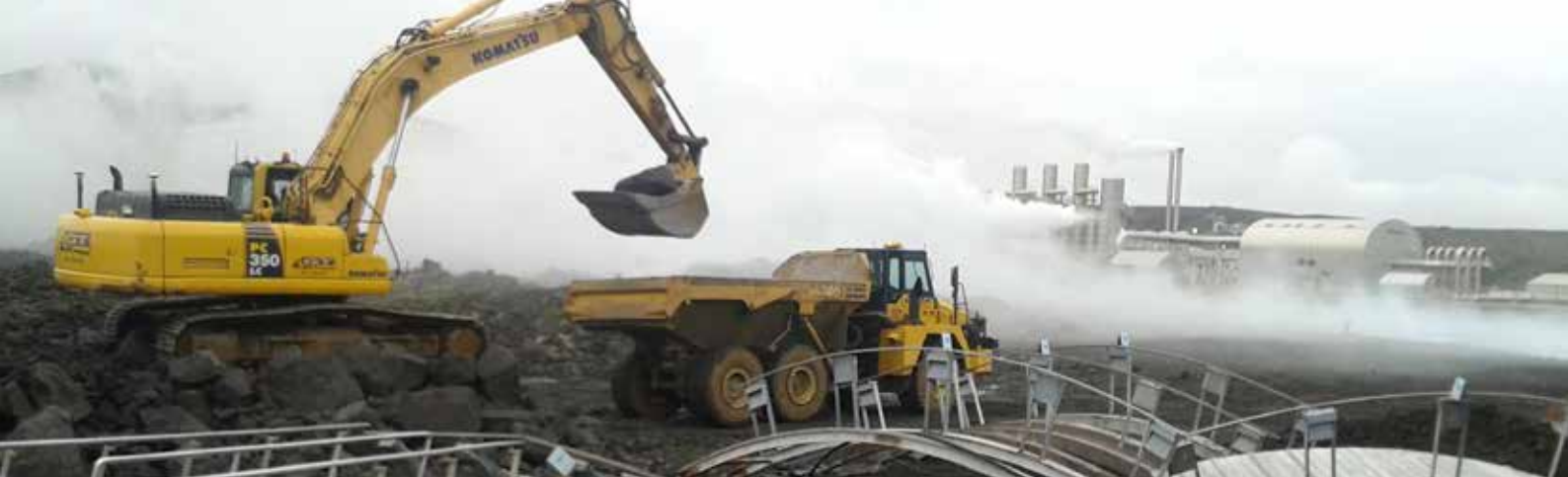
Unnið við Bláa Lónið.
