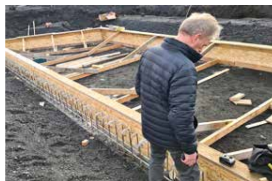
Sigurbjörn að taka út steypumannvirki. Toppstöðin í Elliðarárdal.
