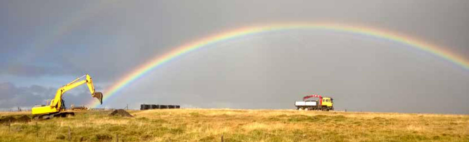
Vinna við lagningu hitaveitu í Hegranesi í Skagafirði.
