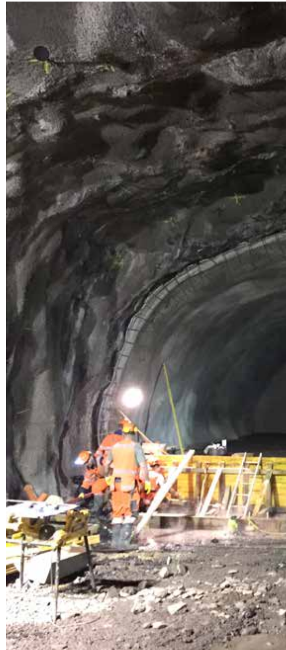
Vinna við Vaðlaheiðargöng.
