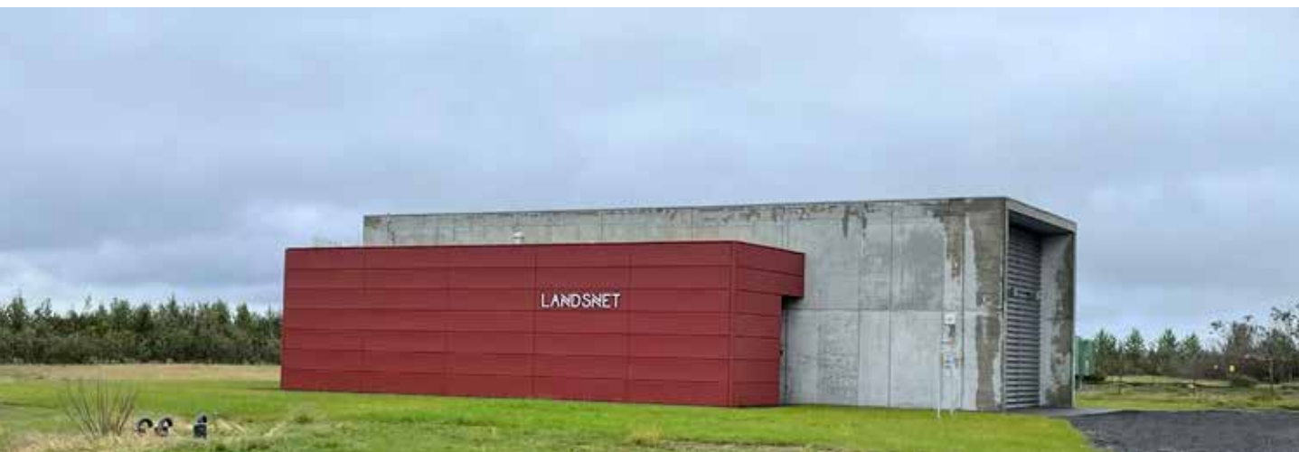
Bygging fyrir Landsnet.
