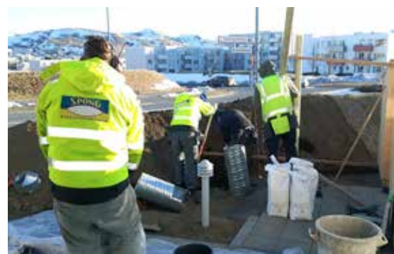
Unnið að sambýli í Þorláksgísla 2-4.
