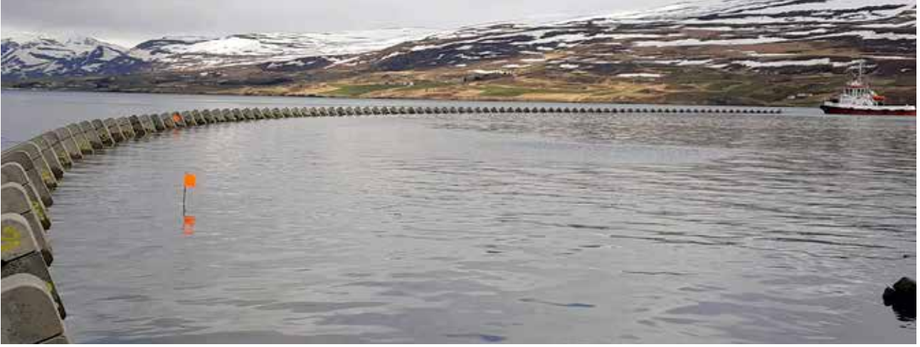
Útrás Akureyri. Útrásarlögn dregin út á fjörð frá frá hreinsistöð í Sandgerðisbót á Akureyri 2019.
