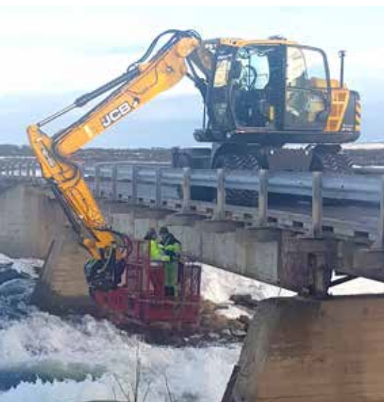
Smávægilegt áhættuatriði yfir Núpafossunum í Aðaldal, en þar þurfti að hengja veitulagnir undir brúna.
