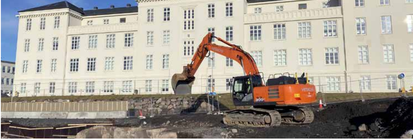
Snókur verktakar vinna jarðvegsvinnu fyrir nýja Landspítalann.
