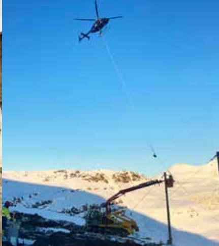
Lengsta raflínu-span á Íslandi liggur frá toppi Brekkugjár niður í Mjóáförð og þurfti að nota þyrlu við strenginguna.
