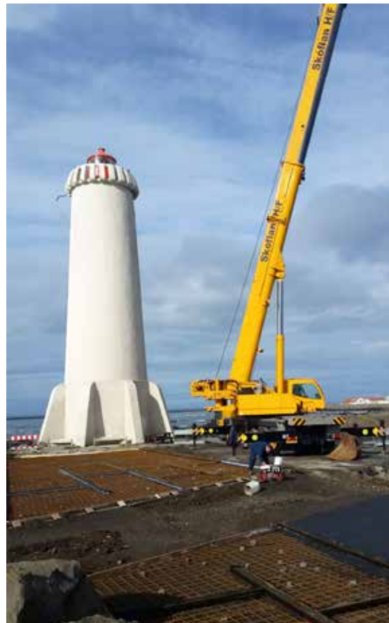
Steypt plön úr svartri steypu á Breið á Akranesi.
