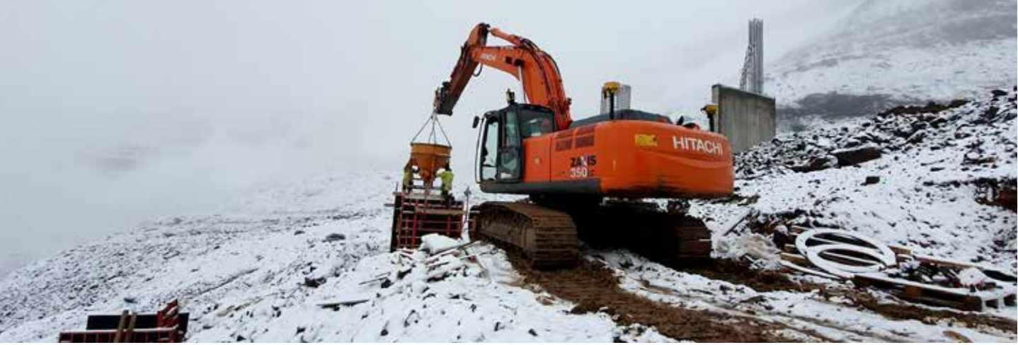
Steypstæði með silói í Hlíðarfelli á Akureyri vegna stóralyftu.
