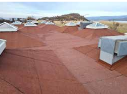
Þak á N1 Egilsstöðum með rauðum dúk.
