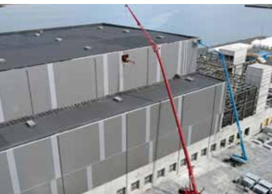
Liebherr LTC 1045-3.1 kraninn að hífa efni í nýbyggingu Innes í Korngörðum.
