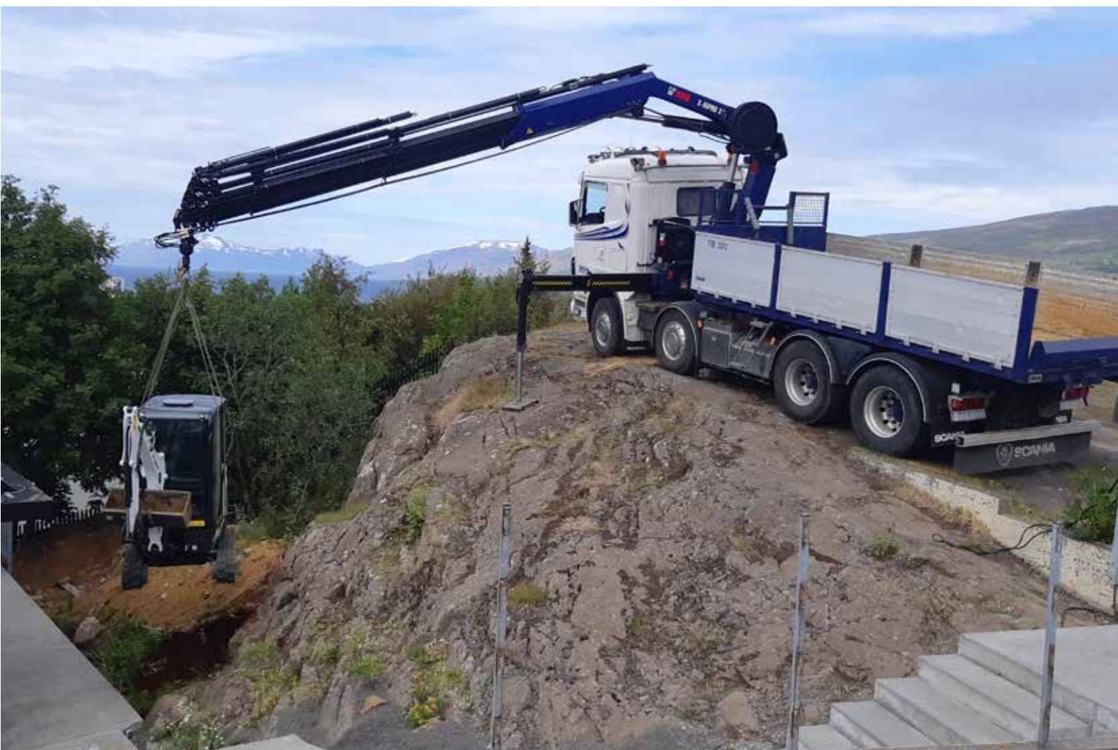
Unnið að lóðagerð við krefjandi aðstæður 2019.
