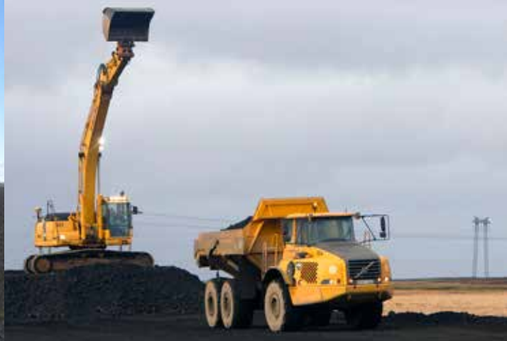
Vinna við fyllingar í tvöföldun Suðurlandsvegjar árið 2011.
