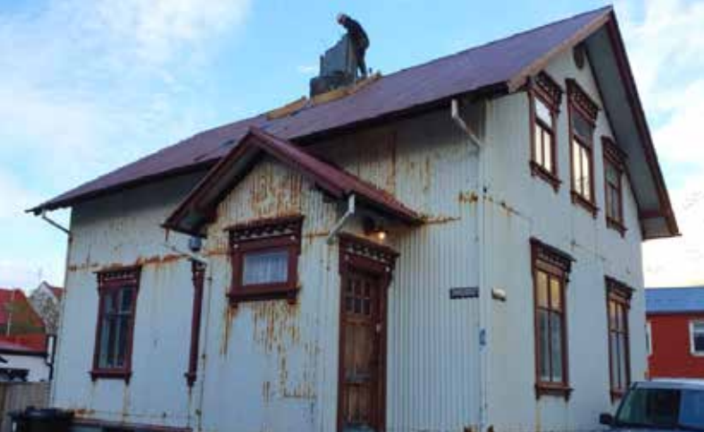
Vinna við að skipta um þak og klæðningu, mynd tekin áður en verkið hófst.
