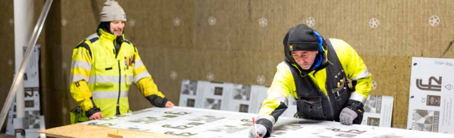
Starfsmenn B.E. Húsbygginga að sniða utanhússklæðningu.
