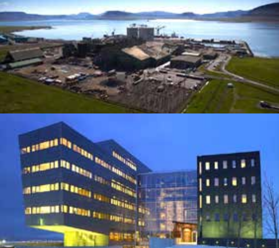
Efri mynd: Elkem, nýlagnir við ofn 3 og viðhald. Neðri mynd: Orkuveita Reykjavíkur, höfuðstöðvar, allar raflagnir.
