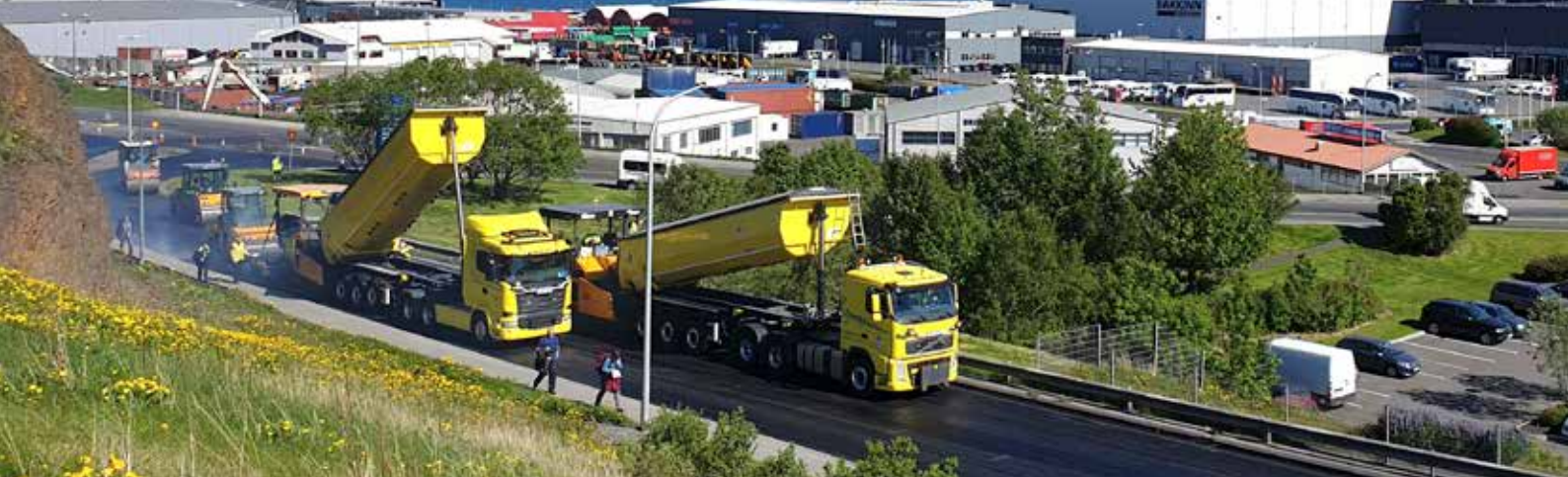
Malbikað í Vatnagörðum Reykjavíkur.
