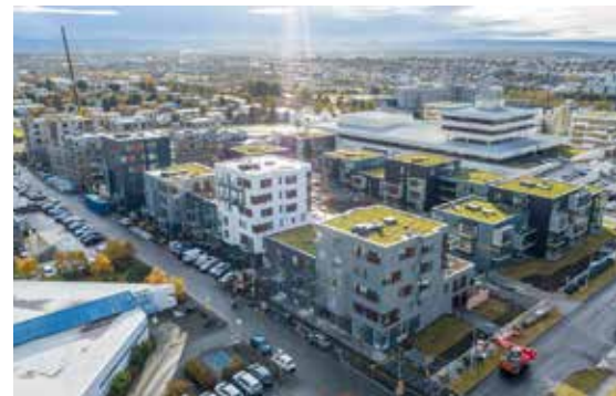
RÚV reiturinn í Efstaleiti, uppsteypa og burðarvirki á 330 íbúðum fyrir Skugga 4 ehf.
