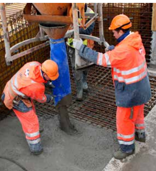
Verið að steypa.
