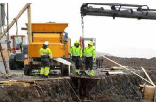
Hér er steypustöð Húsheildar í notkun í fyrsta verkefningu í Örnefasveit.
