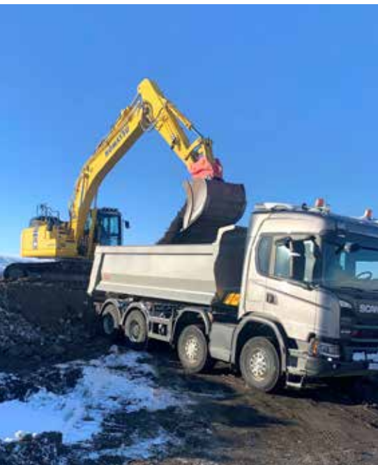
Vinna við slóðagerð í Hólasandslínu HS3-01 við Viða í Reykjadal.
