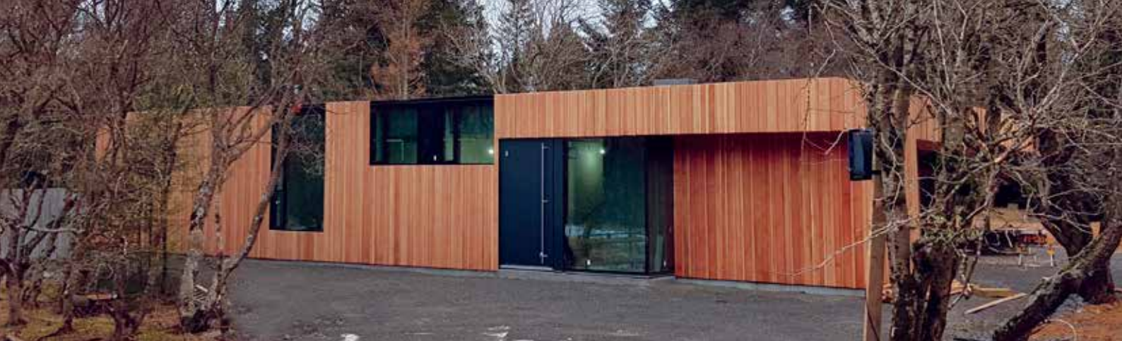
Einbýlishús í byggingu.
