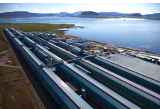
Norðurál, allar raflagnir fasa 2-5.
