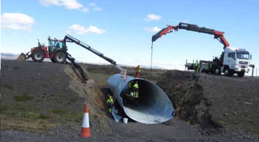
Vinna við undirgöng á Suðurlandsvegi 2011.
