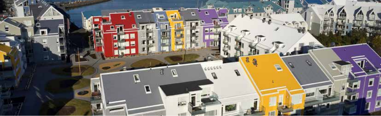
Tangabryggjuhverfið í Reykjavík. Heimavellir eiga 135 íbúðir í 6 fjölbýlishúsum. Félagið keypti íbúðirnar í byggingu árið 2015 og fékk þær afhentar 2017. / Mynd frá Heimavöllum.
