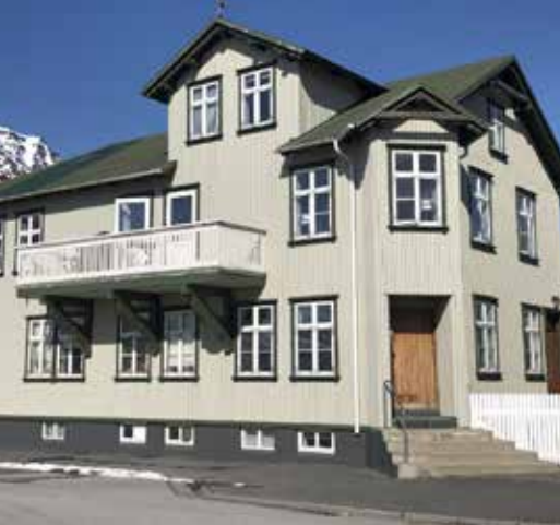
Gamla apótekið á Ísafirði, endurbyggt.
