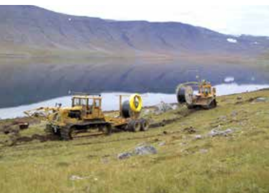
Lagning ljósleiðara í Arnarfirði.
