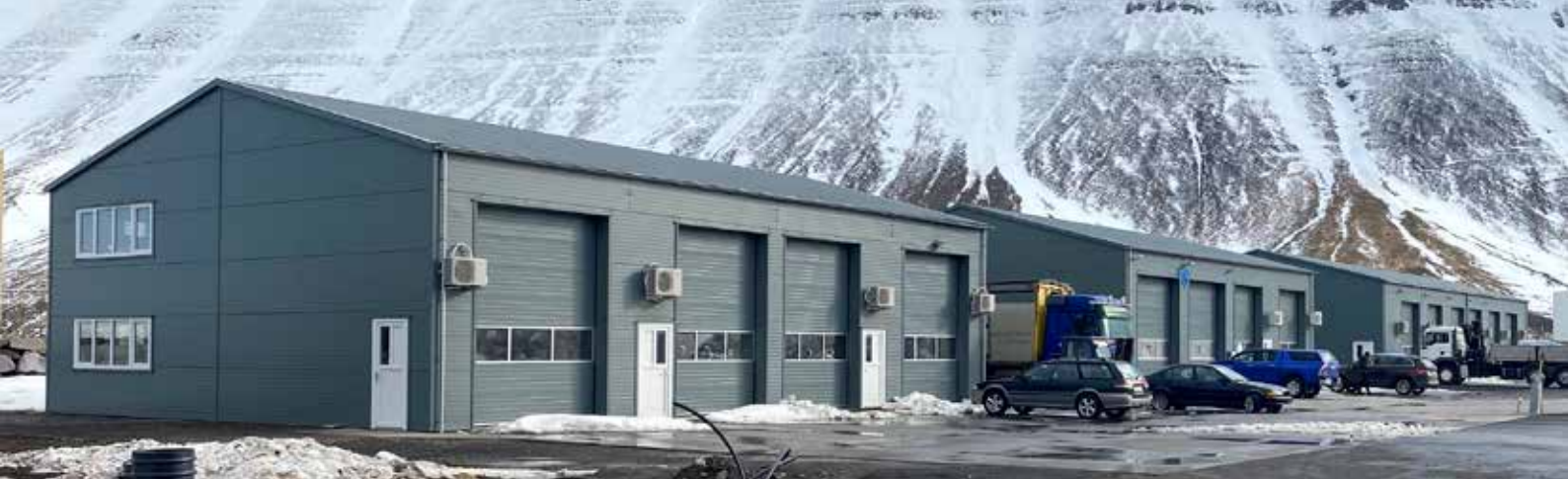
Mávagarðar, geymslubyggingar á Ísafirði.
