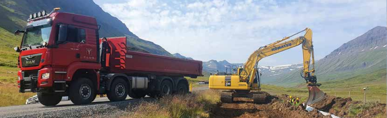
Unnið fyrir Landsnet við lagningu 66 kV jarðstrengs, Neskaupsstaðarlína 2. (2020).
