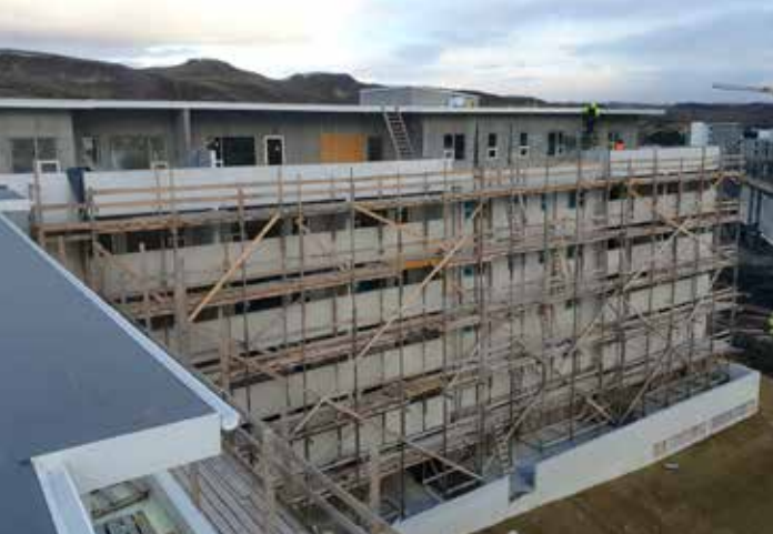
Skyggisbraut 14, 16, og 18 í byggingu.
