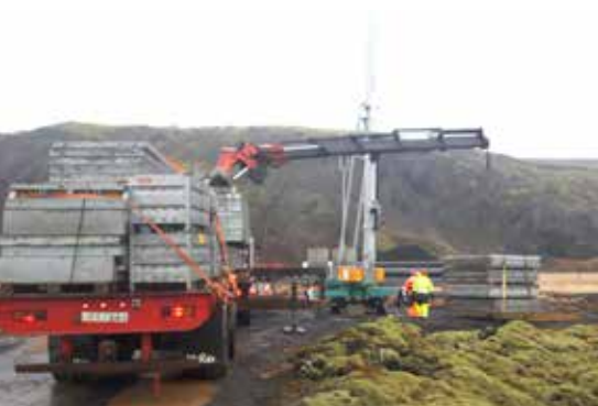
Unnið að stækkun Nesjavallarvirkjunar.
