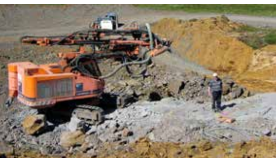
Borun og sprengingar í námu í Skútum.
