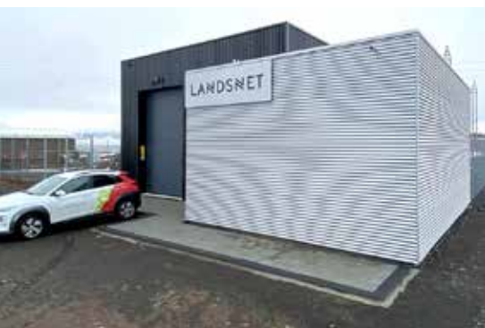
Bygging á spennustöð fyrir Landsnet í Varmahlíð 2020.
