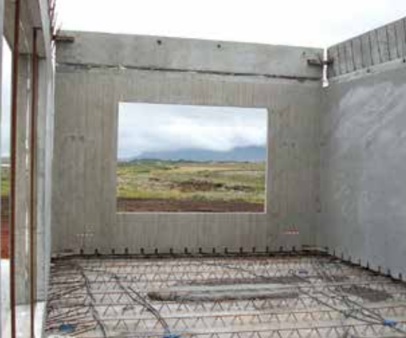
Verið að reisa forsteypt hús frá Einingaverksmiðjunni.
