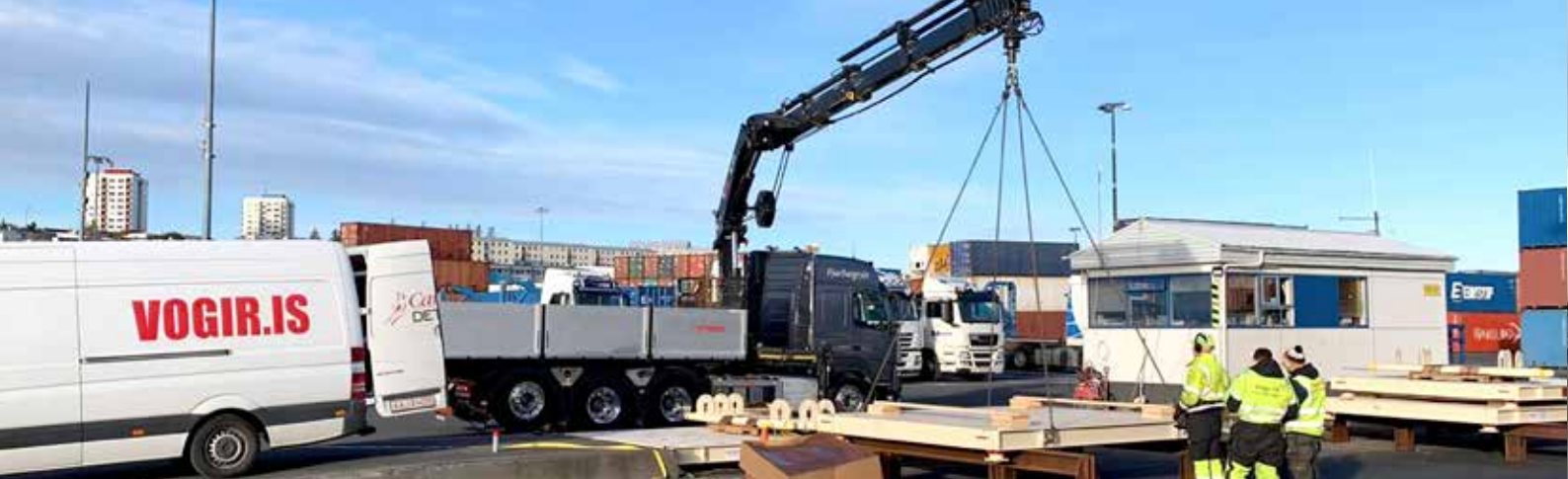
Verið að setja upp bílavogir.
