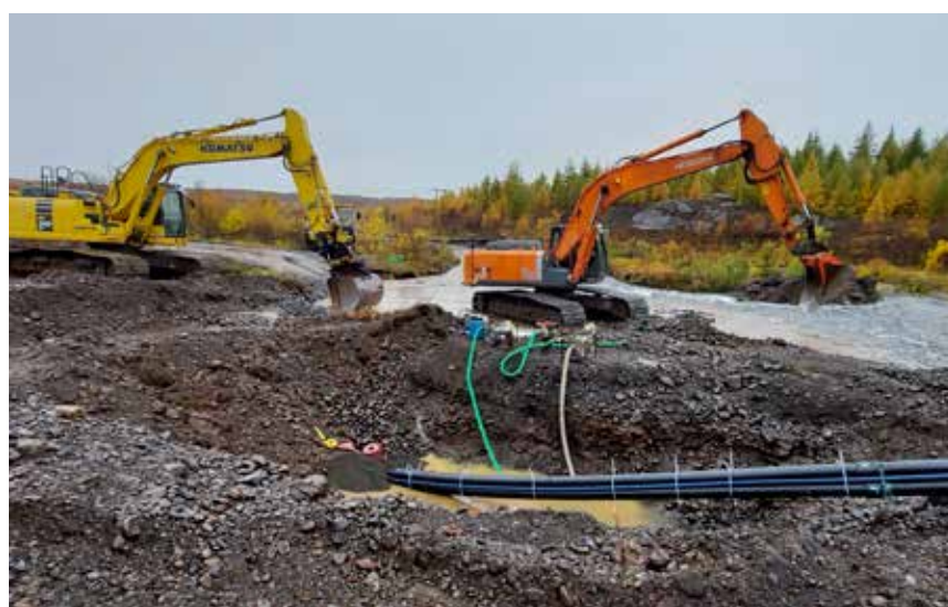
Unnið fyrir Landsnet við lagningu 132 kV jarðstrengs við Miðhúsaá, Eskifjarðarlína 1. (2020).
