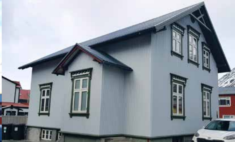
Hér er sama hús og til vinstri, þar sem búið er að skipta um þak og klæðningu.
