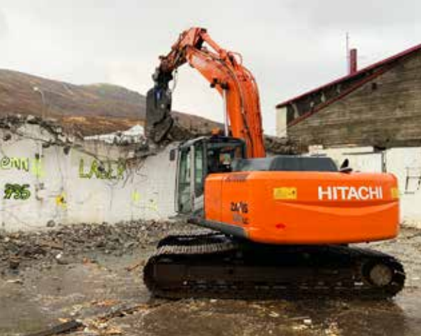
Niðurrif verbúðar og frystihúss Eskju á Eskifirði haustið 2020.
