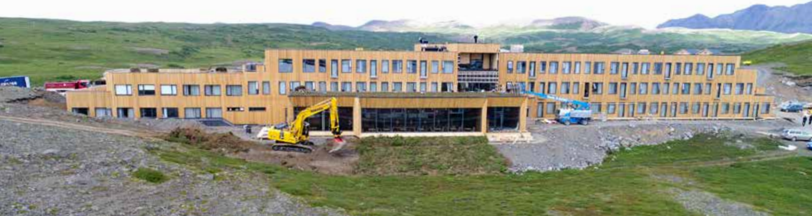
Fosshótel Mývatn í byggingu vorið 2017.
