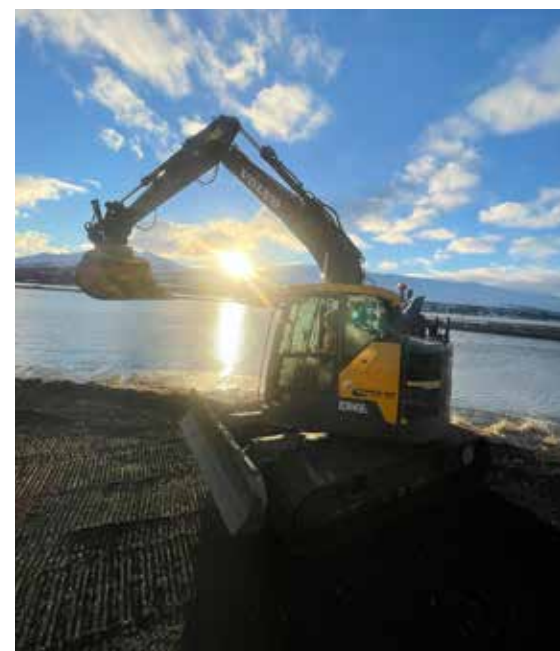
Framkvæmdir að hefjast við Skógarböð.
