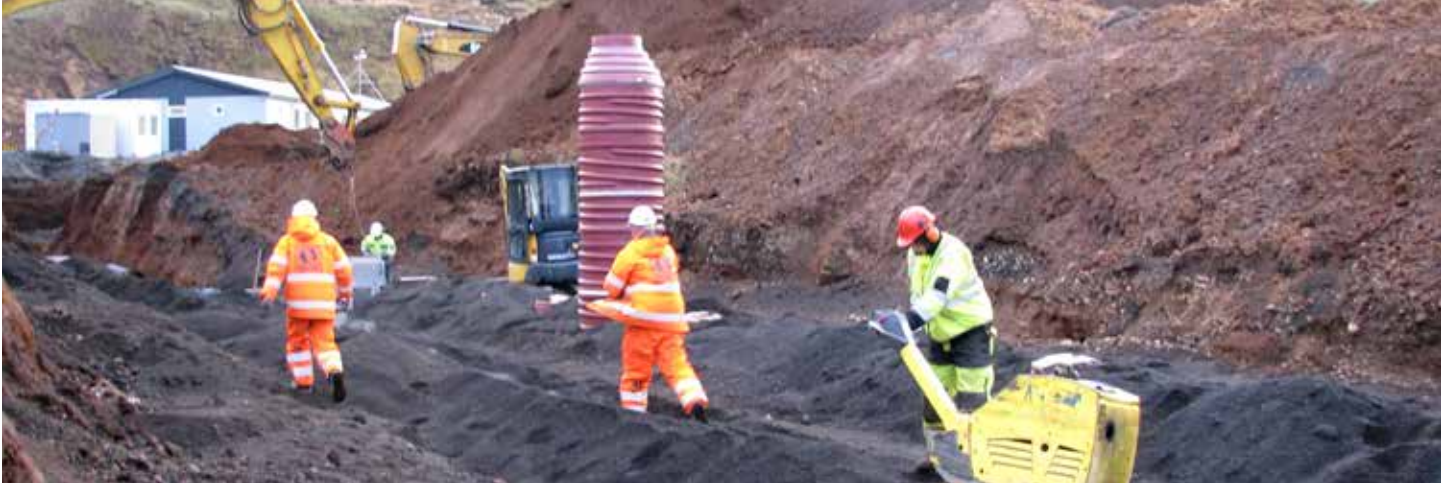
Unnið að stórverkefni.
