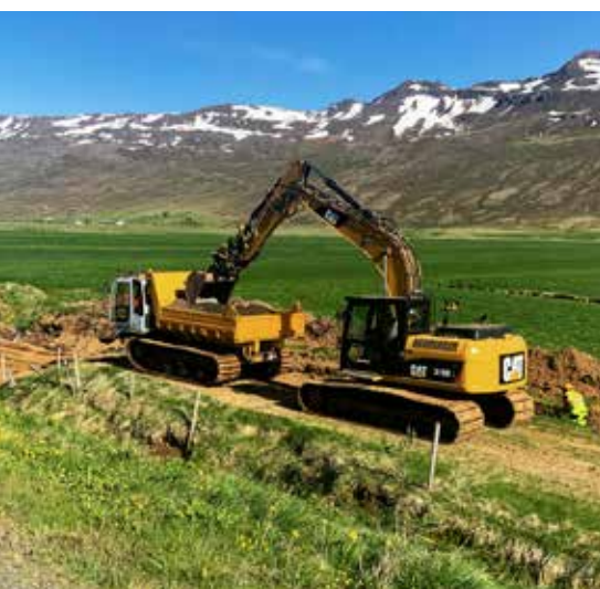
Söndun strengja við lagningu Norðfjarðarlínu (66kW) árið 2020.
