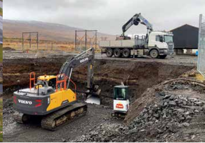
Grunnur tekinn fyrir nýbyggingu Landsnets við Rangárvelli ofan Akureyrar.
