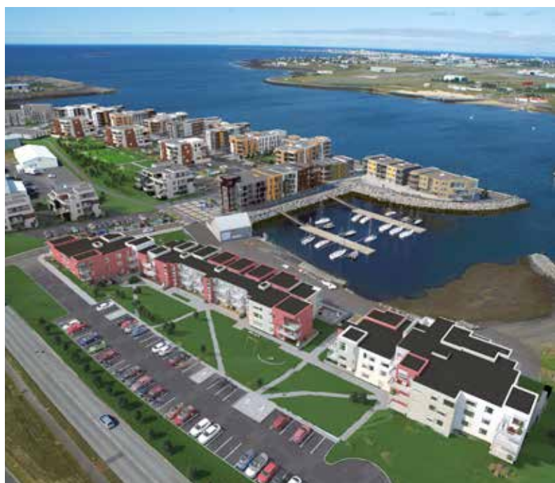
Uppbyggingu Sjálандshverfis í Garðabæ lauk 2019 með afhendingu á 42 íbúða fjölbýlishúsi við Strikið 1a, b og c.
