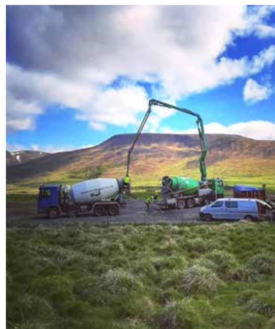
Steypuvinna í Húnavatnssýslu.
