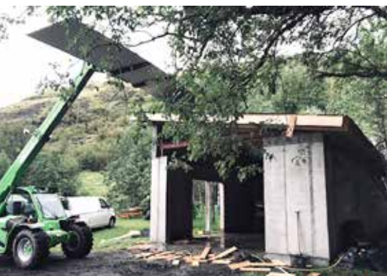
Áhaldahús á byggingarstigi.
