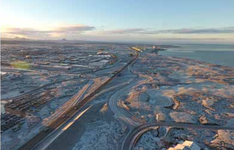
Yfirlit yfir mislægu gatnamótin á mótum Reykjanesbrautar og Krýsuvíkurvegar sem tekin voru í notkun í desember 2017.
