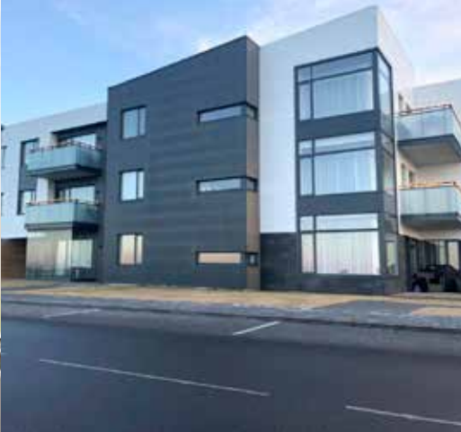
Hallsvegur 15-17, 16 íbúða fjölbýlishús.
