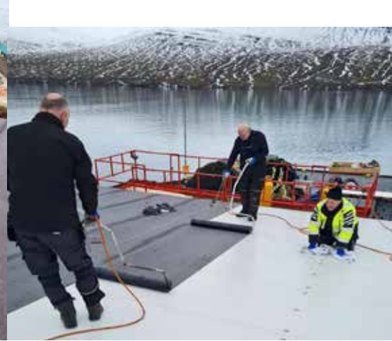
Lagt á frystigeymslu LVF á Fáskrúðsfirði.
