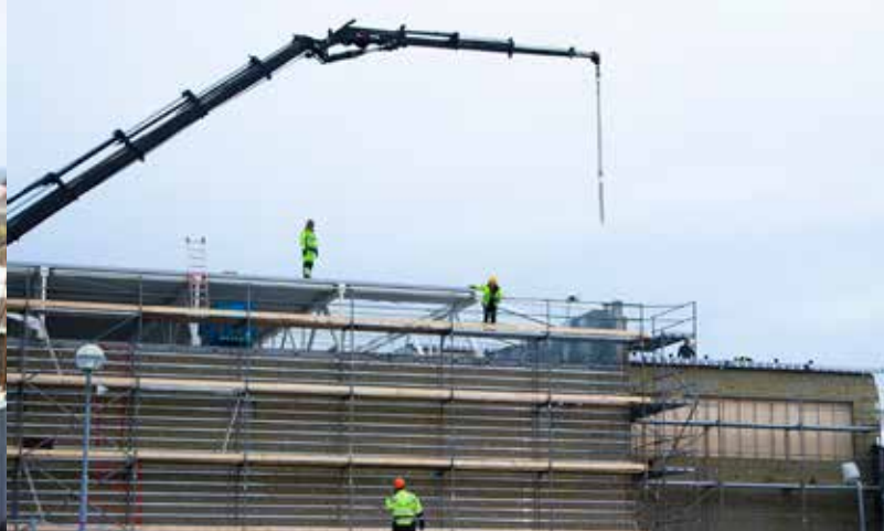
Byggingaframkvæmdir á nýju íþróttarhúsi í Grindavík.
