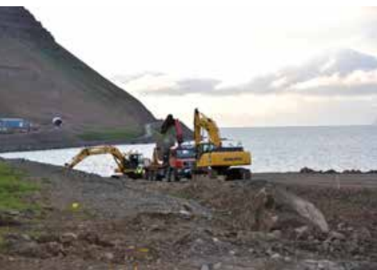
Lagning háspennustrengs frá Ísafirði í Bolungarvík.
