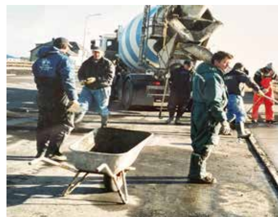
Unnið við lagningu gangstéttar í Garðinum.
