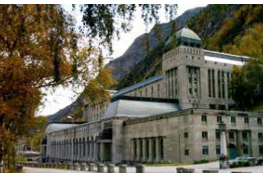
Endurnýjun raflagna í vatnsaflsvirkjunum í Rjukan í Noregi.
