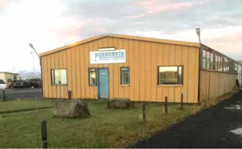
Trésmíðaverkstæði Norðurvíkur á Húsavík.
