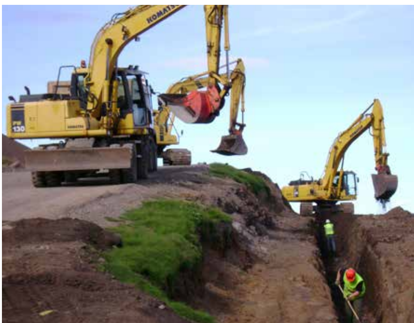
Lagning háspennustrengs á Snæfellsnesi, Grunarfarðarlínu 2.
