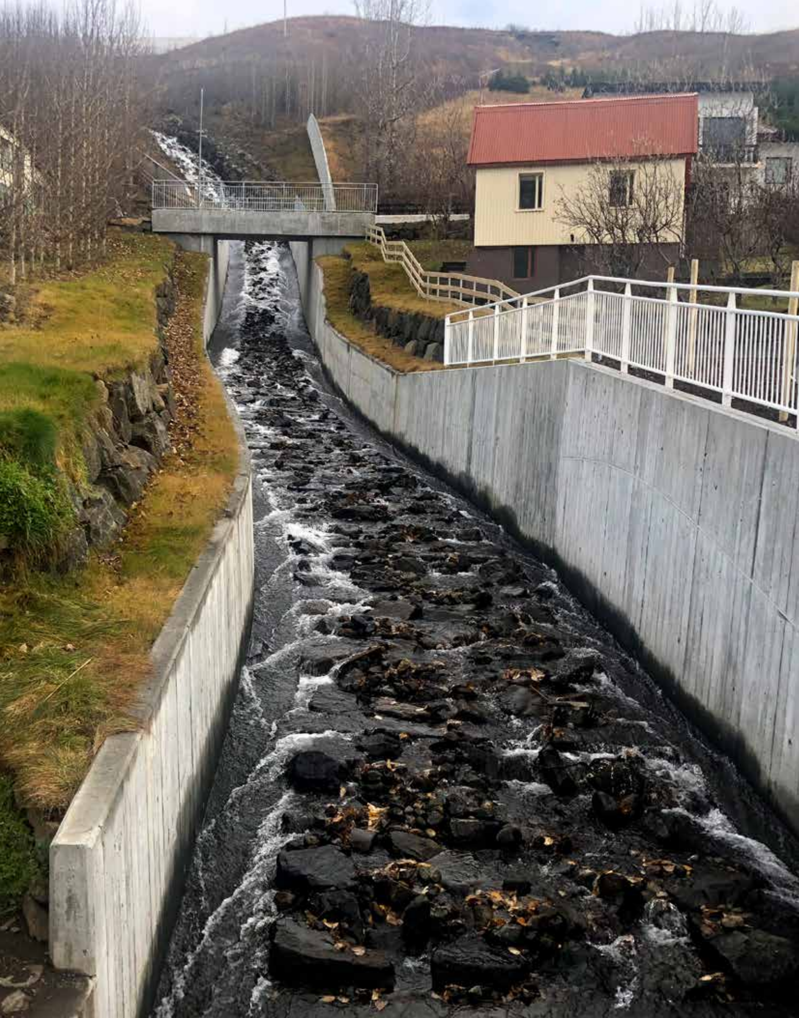
Ofanflóðavarnir, Ljósá Eskifirði. Verkkaupi Ofanflóðasjóður.
