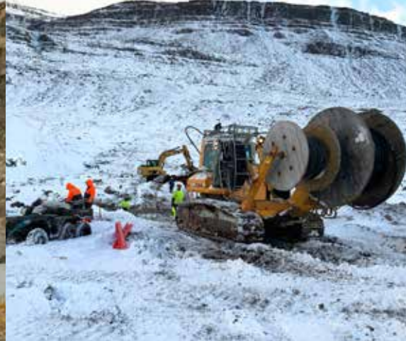
Háspennustrengur og ljósleiðari voru plægðir frá Seyðisfirði til Mjóafjarðar 2019. Myndin er tekin í Austdal við Seyðisfjörð.
