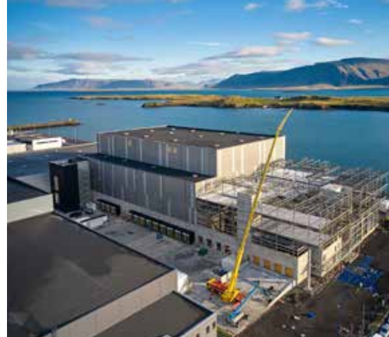
Korngarðar 3 í byggingu, myndin er tekin í september 2020.
