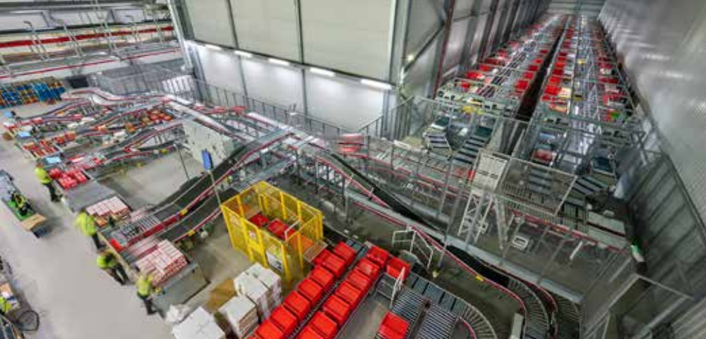
Hátæknivöruhús Innres, Korngörðum 3, tekið í notkun í nóvember 2020.
