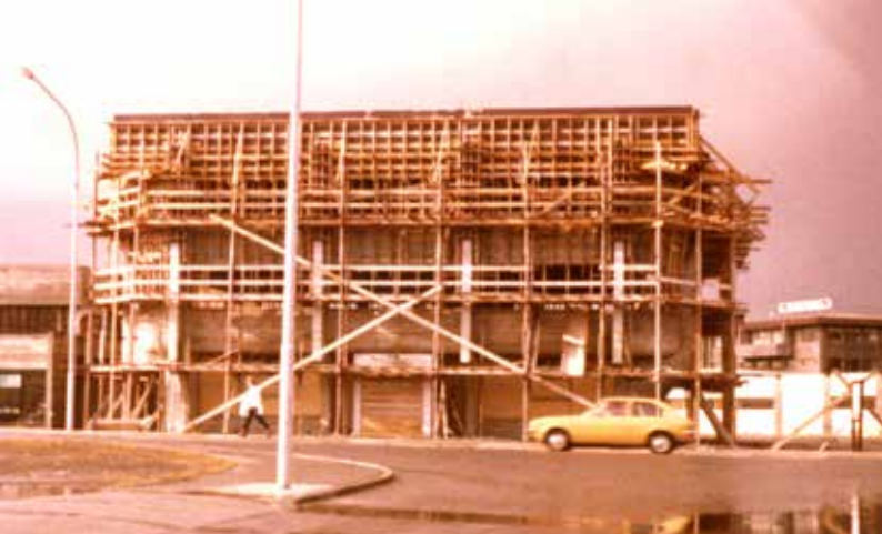
Slegið upp fyrir nýbyggingu Smith & Norland í Nóatúni 4 árið 1983.
